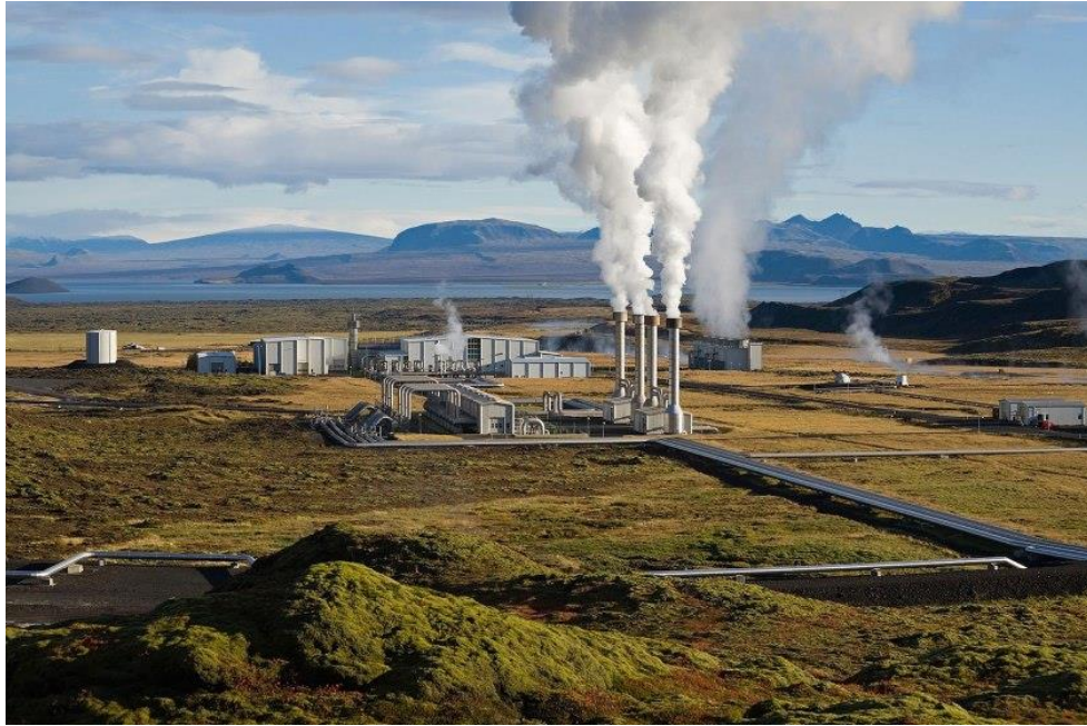
Centrale électrique hydrothermale de Nesjavellir, en Islande.
